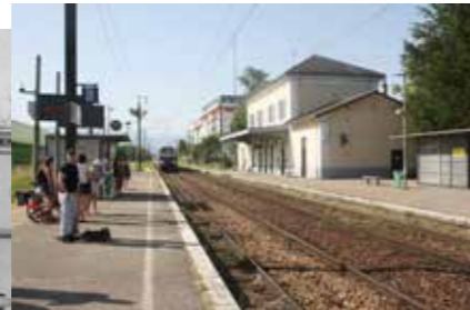
La Gare : Les travaux de la voie ferrée débutent en juillet 1862 et s'achèvent en mai 1865. Le 5 juillet 1866, la ligne est ouverte au trafic régulier. Tout transit est obligatoirement par la gare jusqu'en 1920.
