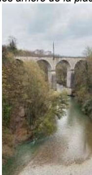
Le Chéran, le pont de la voie ferrée
