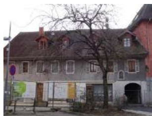
bâtiments de l'ancien couvent des Bernardines Montpelaz-r-3_p593-c2
