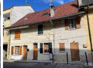
maison de faubourg - ensemble Terreaux-r-5-7-9_p45-44- 43-c3
