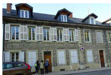
maisons bourgeoises avec modénature, mais dénaturés par dégroutage Place d'Armes-pl-1-3-5_p26-21-20 -c2
