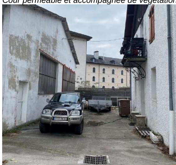
Avenue de la Gare_p69 Vue sur le patrimoine bâti altérée par la faible qualité de traitement de la cour.
