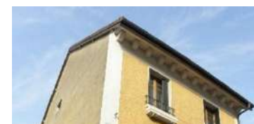
Corniche haute à modillons qui, avec la toiture, constituent le couronnement
