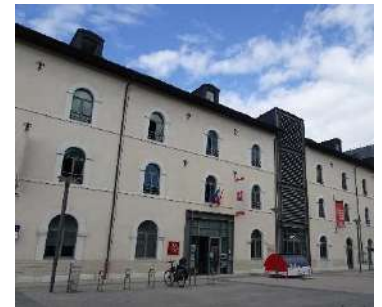
Place de la Manufacture, bâtiment XIX ème : régularité militaire des ouvertures avec encadrement peu marqué et cordon horizontal
