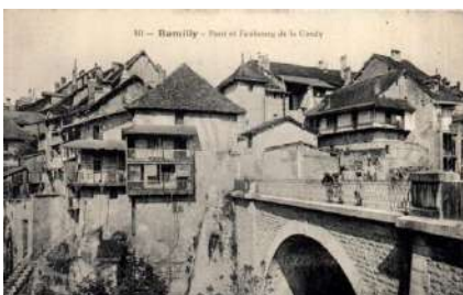
Le Pont de Curdy, accès des habitations aux jardins / à la rivière par des escaliers
