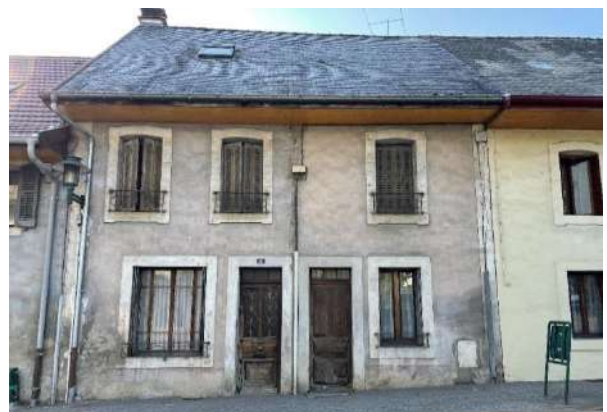
Rue de la Sauge : maison de faubourg à 2 niveaux ; 2 travées par parcelle, ouverture jumelée en rez-de chaussée, l'alignement n'est pas recherché, les maçonneries sont enduites, les encadrements sont
