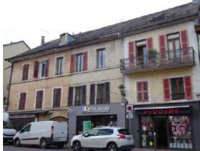
Faubourg des Terreaux Avenue Gantin
