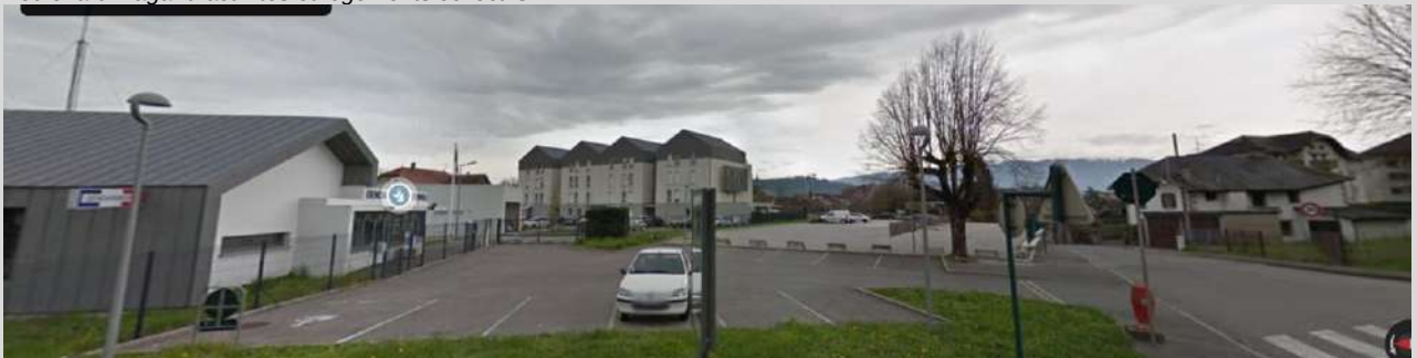
boulevard Dagand gendarmerie, logements collectifs récents, parking et secteur en mutation (démolition-reconstruction)
