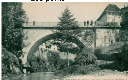
Le Pont de Curdy depuis la Néphaz, haut mur de soutènement des jardins
