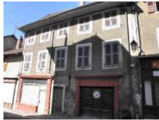
immeuble XIX ème Boucheries-r-6-8_p547-168 -c2
