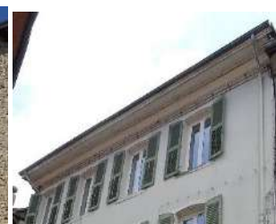
Rue du Pont neuf : passée de toit travaillée en corniche
