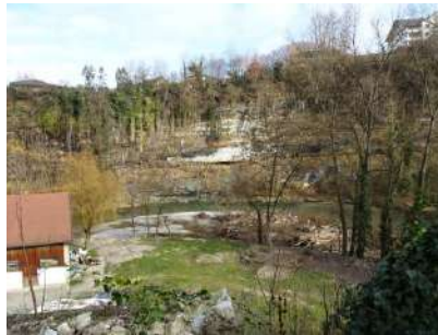
Berges et bâtiments du chemin Bernoud
