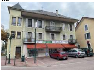
Avenue de la Gare_p71 – c3
