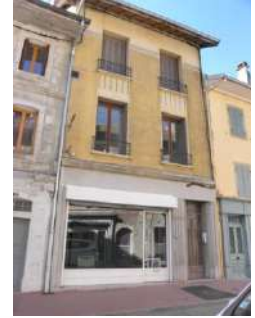
maison de bourg, façade style années 1930 Filaterie-r-16_p144 -c2
