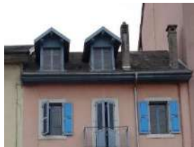
Place d'Armes : lucarnes alignées avec les fenêtres
