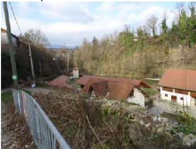
Berges et bâtiments du chemin Bernoud
