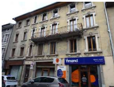
Rue du Pont Neuf : immeuble avec modénature XIX ème , regroupement de 2 parcelles, rez-de chaussée marqué, recherche de symétrie.
