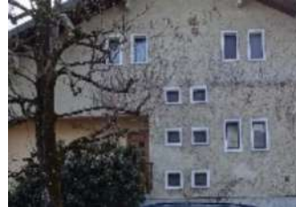
Multiplication des ouvertures : les précadres en béton font ressortir les matériaux la composition géométrique
