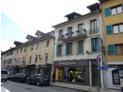
Faubourg des Terreaux Avenue Gantin
