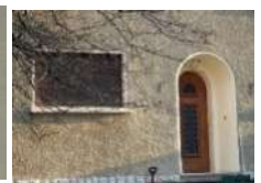
Volet roulant d'origine avec caisson intégré et porte bois avec vitrage
