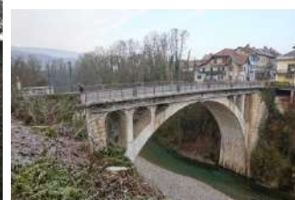
Pont Neuf en béton 1942 c2
