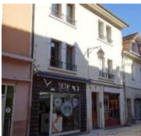
immeuble avec façade début XX ème Montpelaz-r-11-13_p43 -c2
