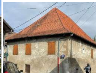
Rue du Collège : toiture à 4 pans coyau
