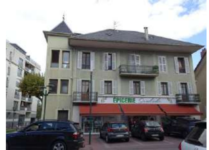
Faubourg des Terreaux Avenue Gantin
