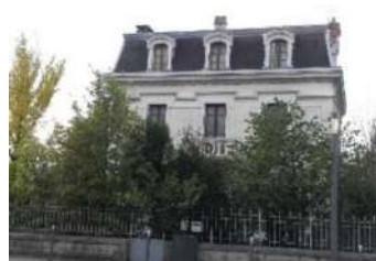
maison bourgeoise avec toiture à la Mansart, corniche à modillons, lucarne moulurée Gantin-av-40_p2 -c1
