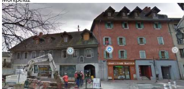
Façade des bâtiments donnant sur la rue Montpelaz, n°3-5
