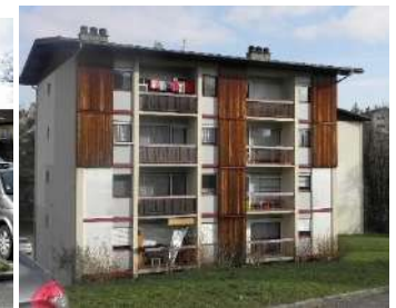
façade arrière avec loggias
