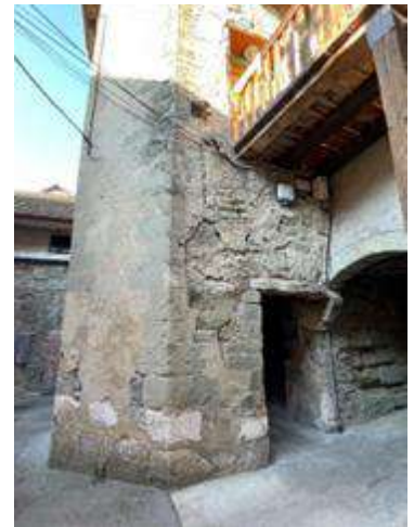
escalier avec coursive
