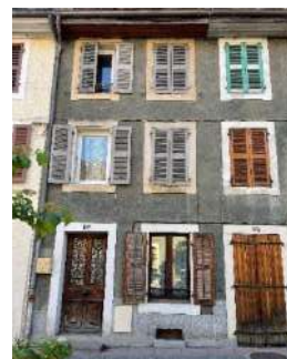
anciennes maisons de faubourg regroupées en immeuble Genève-r-21-23_p117-118 -c2
