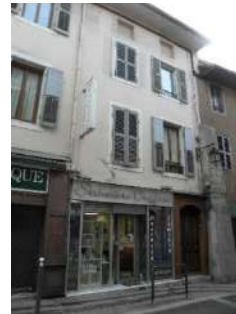
maison de bourg Pont-Neuf-r-8_p573 -c2
