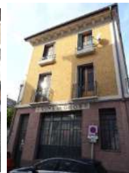
petit immeuble XIX ème avec modénature marquée, belle menuiserie en acier Girod-r-4_p239 c2
