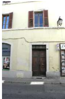
Rue Centrale : porte à panneau et imposte vitrée
