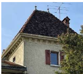
Rue GI De Gaulle: toiture à 4 pans sur tour, corniche à modillons
