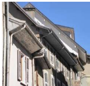
Rue des Boucheries : importance de la passée de toit
