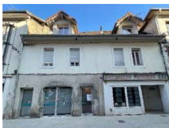
maisons de bourg, ancien hôtel Montpelaz-r-13_p43 -c2
