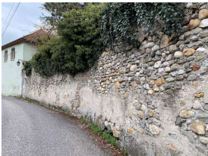
Mur de clôture, Rue du Collège_p639-638
