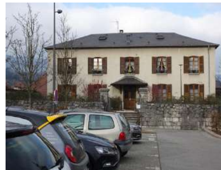
presbytère (ancienne cure), Pass. de l'église-2_p83-c2
