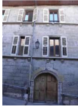
Rue de Hauteville, maison des Comtes de Hauteville : façade alignée sur la rue
