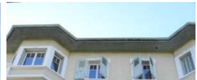
Rue Édouard André : passée de toit caissonnée sur immeuble Art Déco
