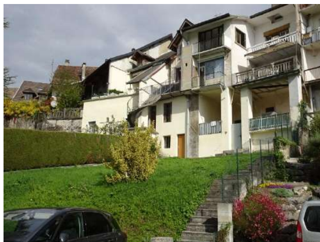
Rue des Remparts, arrière rue Montpelaz
