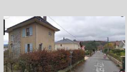
Lotissement pavillonnaire rue des Acacias
