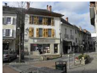
maisons de bourg, ensemble De Gaulle-r 26 à 16-c2 et c3
