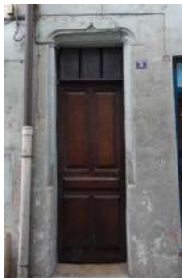
rue Montpelaz : vantaux bois à panneaux et imposte vitrée, linteau sculpté.
