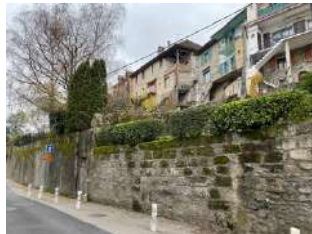
Rue des Remparts_p123-122-441 – c2
