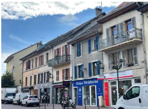
Faubourg des Terreaux, avenue Gantin
