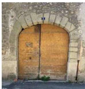
rue de Hauteville : vantaux d'un porche en planches cloutées
