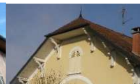
Route de Fuly : traitement d'une passée de toit sur maison d'XX ème
