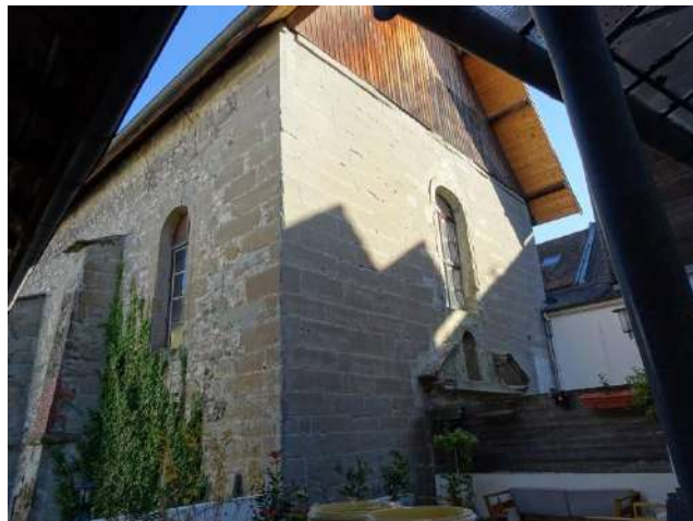
Façade de la chapelle donnant sur la cour intérieure du 3-5 rue Montpelaz
