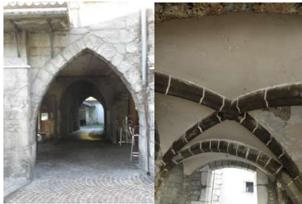
Accès cour arrière
