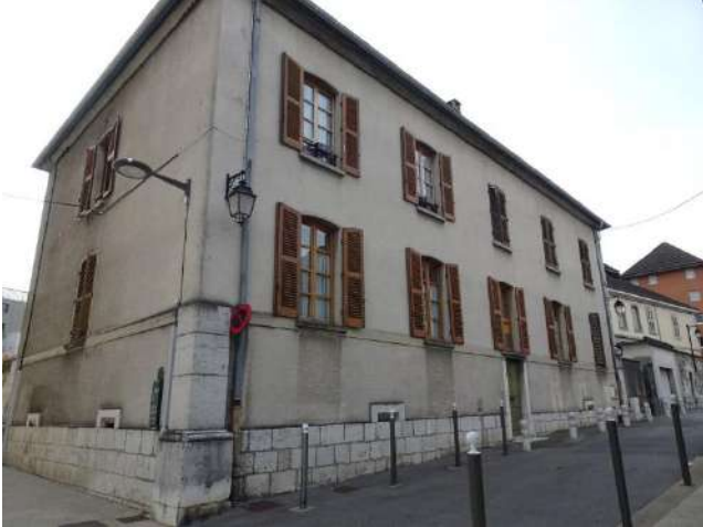
À l'emplacement du prieuré on a construit le presbytère à la fin du XIXe siècle
