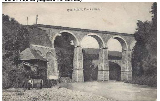
Le viaduc du chemin de fer et le Pont-Neuf à l'arrière plan.
