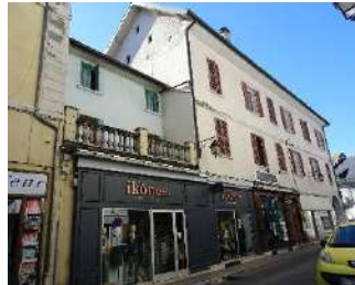
immeuble XIX ème Centrale-r-2-4 et Hôtel de Ville-pl-1_p250 -c2
