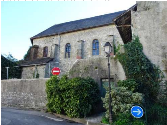
il reste la chapelle du couvent visible depuis la rue des Écoles
