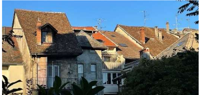
Toitures de la rue Montpelaz vue depuis la rue des remparts : versant à 2 pans sur cour en tuile écailles et mécanique, présence ponctuelle de lucarnes et cheminées en brique.
