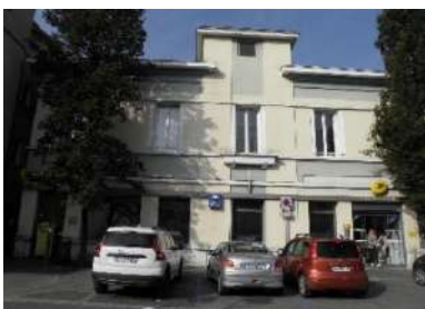
La Poste : bâtiment en béton des années 1930/40
