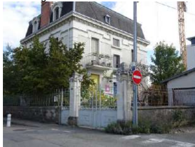
Maison 40 av Gantin_p2
