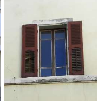
Rue Centrale : fenêtre bois traditionnelle, volet persienné avec lames orientables, menuiserie XIXème avec partition verticale du vitrage
