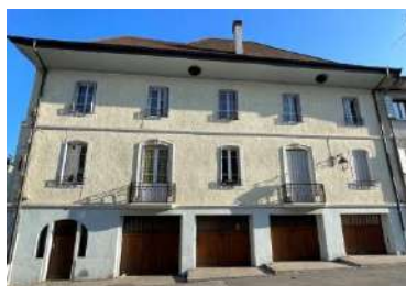
Rue de l'Hôtel de Ville : ancienne maison noble transformée en immeuble au début XX ème : recherche de symétrie, le traitement du soubassement est différencié, ferronnerie, et menuiseries de qualité (style art-déco).
