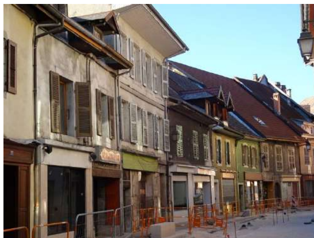
Rue Montpelaz, Alignement de maisons de bourg, très anciennes. R+1 ou plus rarement R+2 implantées au droit de la rue, mais des étages supplémentaires au-dessous du niveau de la rue côté rivière
