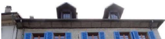
Rue du Pont Neuf : corniche pierre sous toiture
