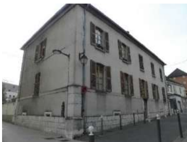
Pass. de l'église ; ancienne cure bâtiment fin XIX ème devenue école publique Léon Bailly : régularité et symétrie des ouvertures, modénature peu marquée.
