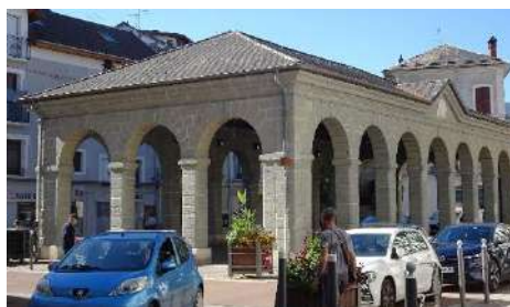
Halle place de la Grenette, reconstruite au XIX ème siècle
