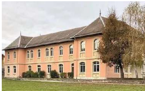
Passage de la Visitation, ancien couvent des Visitandines, bâtiment fin XIX ème : régularité et symétrie des ouvertures, modénature marquée
