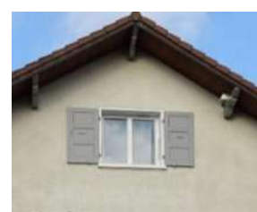
Menuiserie pvc à grand vitrage, volets à panneaux aplatis car peints uniformément en gris pastel
