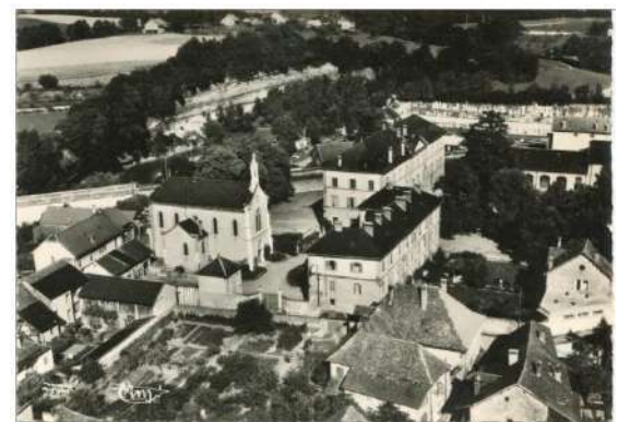
Pensionnat, collège et chapelle dans le clos de l'ancien couvent de la Visitation
