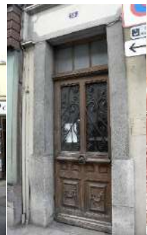
Rue des Boucheries : porte à panneau et imposte vitrée
