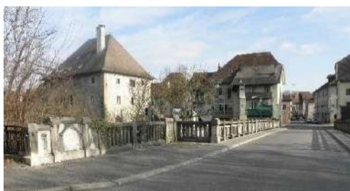
Pont Edouard André en béton, 1935 c2
