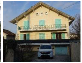
Béton enduit, pierre plaquée ou bois en plaquage, précadres des menuiseries, balcon filant au premier étage
