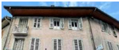
Rue du Pont neuf : passée de toit simple en planche suivant la pente du toit
