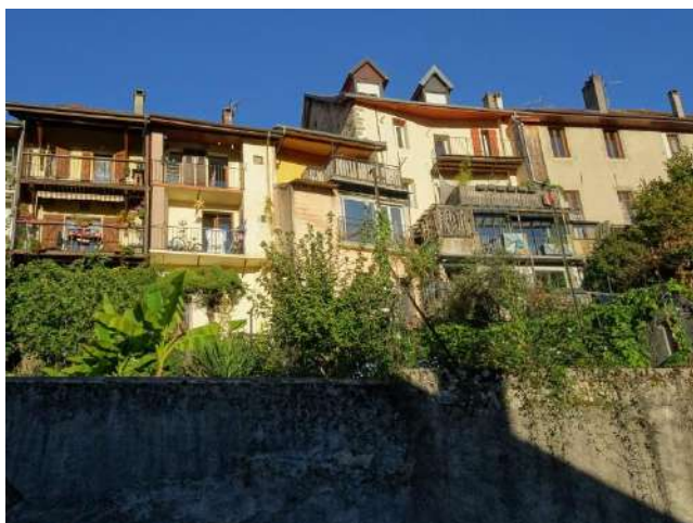
Rue des Remparts, arrière rue Montpelaz
