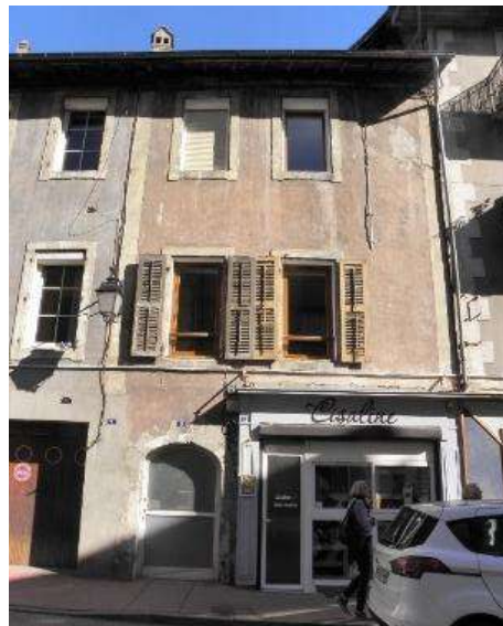
Rue Filaterie : maison de bourg à 3 niveaux , facade entièrement enduite du sol à la toiture, encadrements marqués des baies, alignement recherché depuis la porte d'entrée au 3 ème étage.
