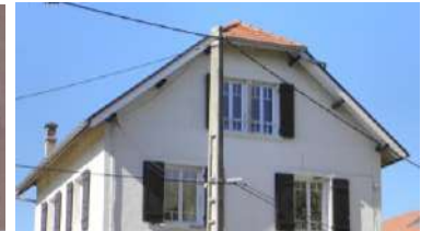
Av Roosevelt: toiture avec croupe, pannes apparentes
