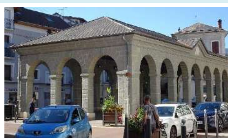
Halle en pierre XIX ème Halle place de la Grenette -c1
