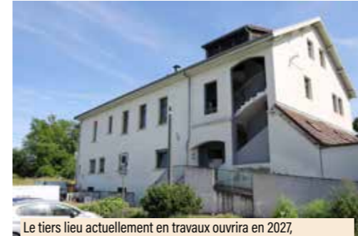
Le tiers lieu actuellement en travaux ouvrira en 2027, au premier étage du bâtiment situé promenade Philippe Perron
